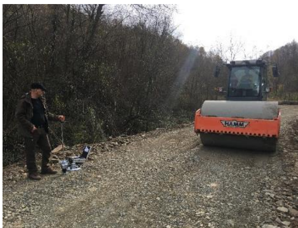
Слика 19: Испитивање након више пролазака ваљка
