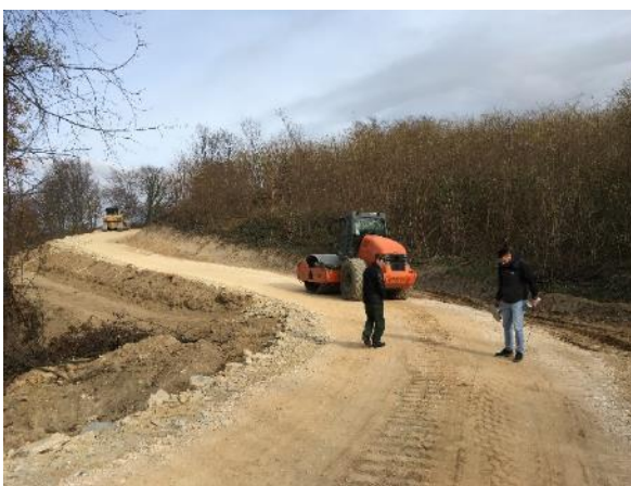
Слика 23: Мерење након више пролазака ваљка
