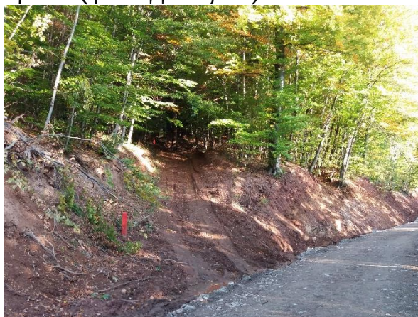
Слика 11: Веза тракторске влаке са шумским путем
