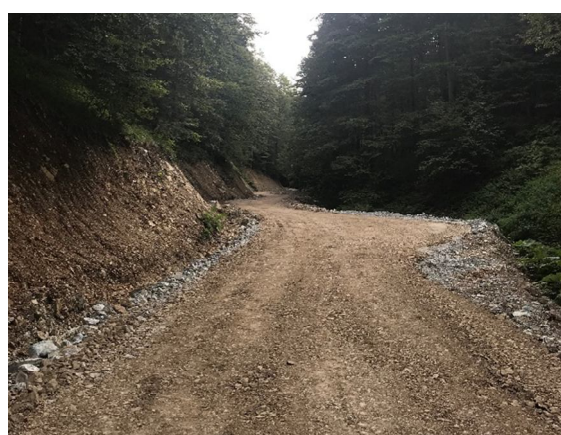
Слика 73: Шумски пут "Бурмански поток - Ћелавуша" – израђена коловозна конструкција
