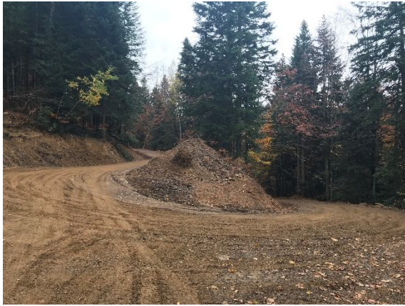
Слика 45: Припремљена постељица на шумском путу "Кружни пут – Бела река"
