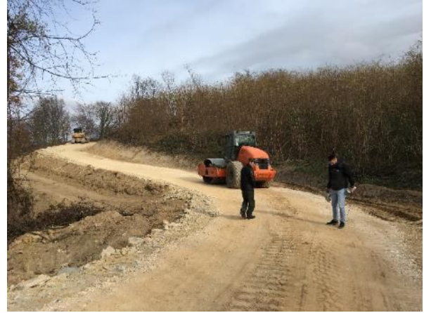
Слика 43: Мерење након више пролазака ваљка Ловачки дом-Милојковача
