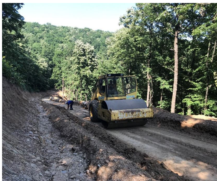
Слика 86: Ваљање постељице на шумском путу "Пољана - Ловачко имање"
