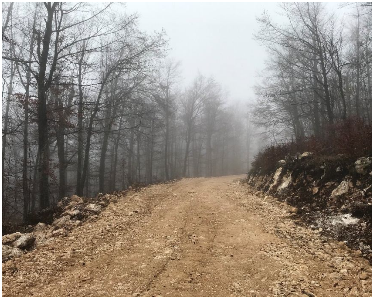
Слика 82: Шумски пут „Торовиште – Копривно брдо“ након израђеног носећег слоја коловозне конструкције
