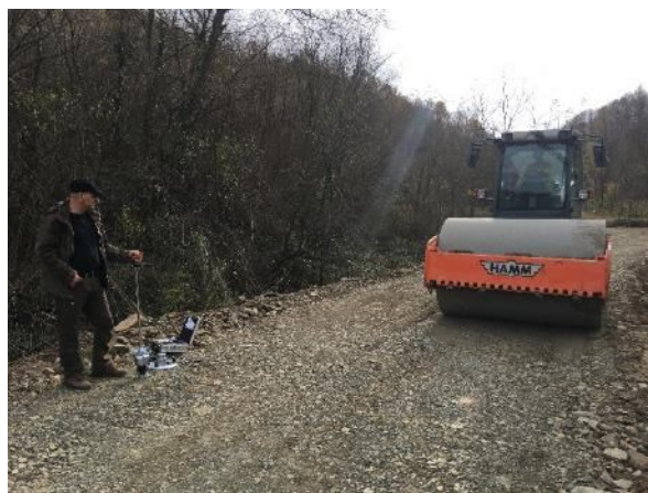
Слика 39: Испитивање након више пролазака ваљка
