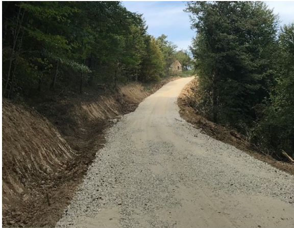
Слика 47: Шумски пут "Плавчево - Штубеј" након изградње 2020. год.
