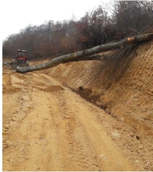
Слика 67: Шумски пут „Девотин – Стамболка – Китке“ у изградњи
