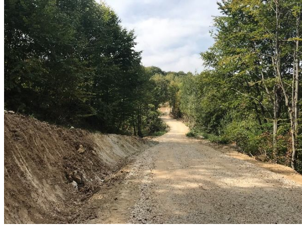
Слика 48: Шумски пут "Плавчево - Штубеј" након изградње 2020. год.
