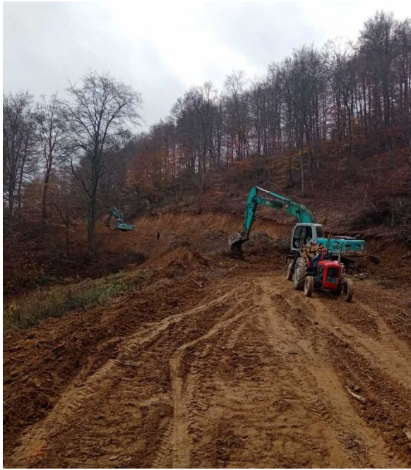
Слика 66: Шумски пут „Девотин – Стамболка – Китке“ у изградњи
