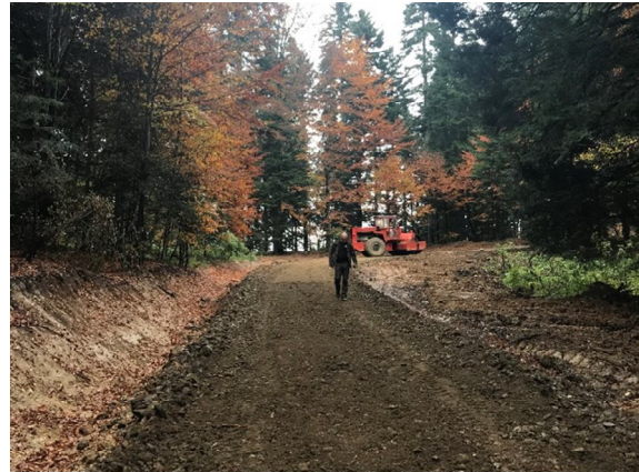
Слика 46: Израда коловозне конструкције на шумском путу „Кружни пут – Бела река“
