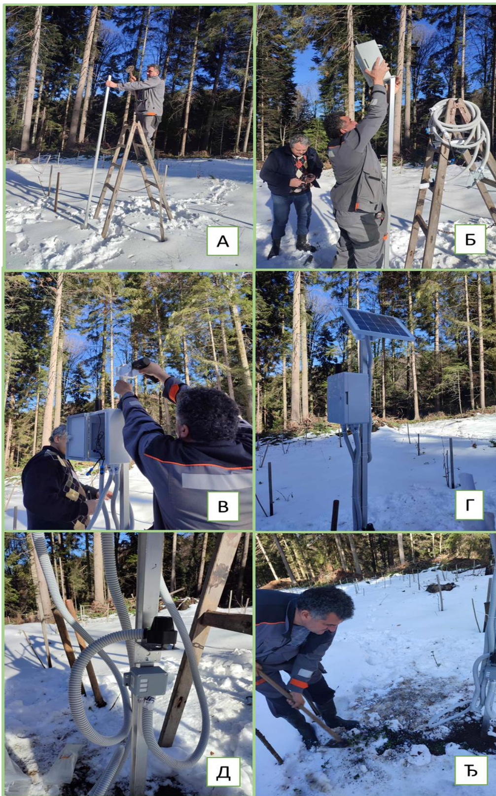
Фото-таблица 5.1. Постављање сензорне станице на терену: постављање носача (А), постављање централне кутије (Б), постављање носача за соларну ћелију (В), монтирани соларна ћелија и централна кутија (Г), постављени сензори за инсолацију, температуру и важност ваздуха (Д) и постављање сензора за температуру и влагу земљишта (Ђ)
